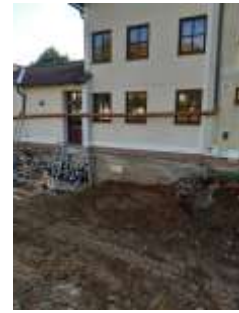
Baufortschritt Volksschule Sallingberg
